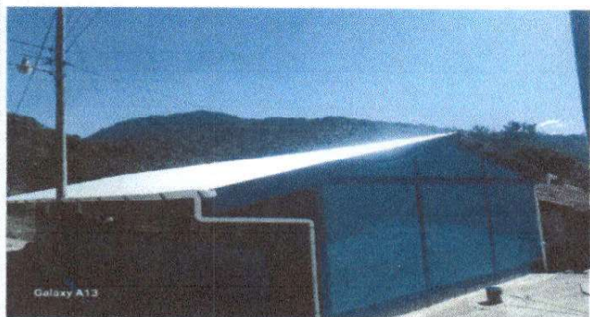
FOTO 1: Sustrución de lamina, por lamina troquela aluzinc calibre 26 (aula 1 y 2)
