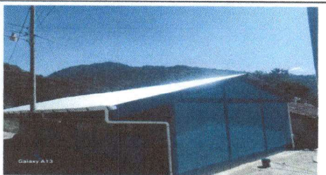
FOTO 5: Sustrución de canal de metal por canal de PVC (aula 1 y 2)
