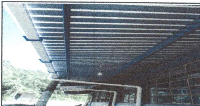
FOTO 6: Sustrución de soporte o pescante metal para canal de pvc (aula 1 y 2)
