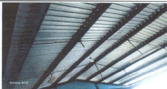
FOTO 3: Mantenimiento a estructura de soporte de metal (aula 1 y 2)
